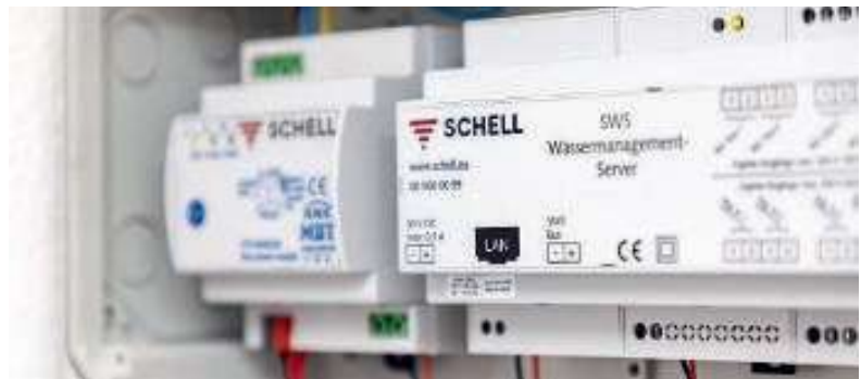
Digitales Wassermanagement: Via SWS-Server können u.a. Stagnationsspülungen und Armaturen-Parameter zentral und flexibel programmiert werden.
