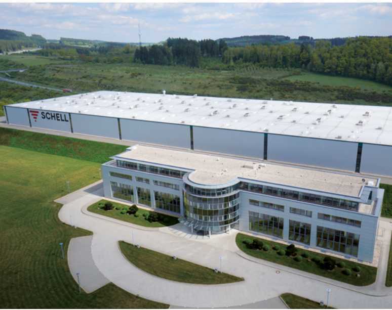
Werk 1 Produktion mit Verwaltungsgebäude und Schulungszentrum
