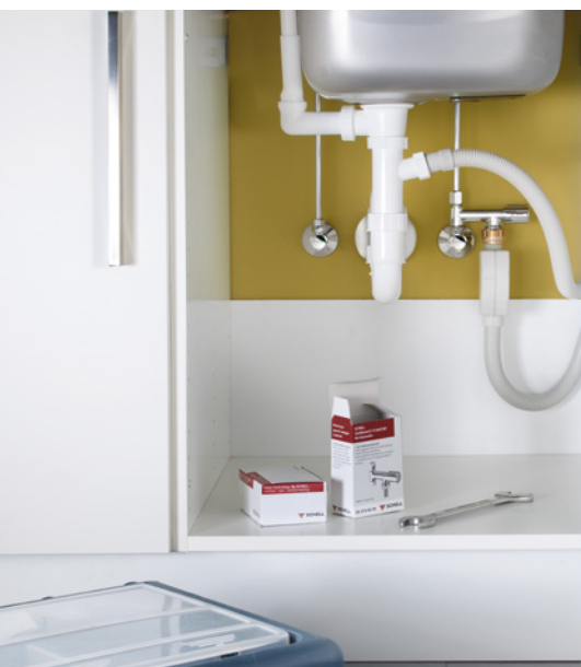
Geräteventil COMFORT (Anschluss an eigensichere Waschmaschine)
